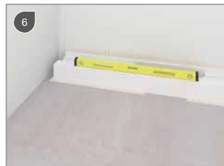
Vyrovnajzte polystyrénový blok do vodorovnej polohy
