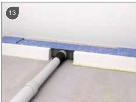
13 Pripojte odpadovú rúrku DN 50 na redukciu
