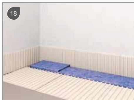
18 Aplikujte flexibilné lepidlo podľa EN 12004 C2 v šírke 20cm na plochy v priestore aplikácie izolačnej tkaniny
