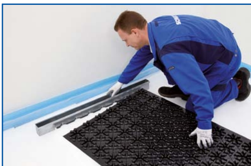
5. Systémový modul air conomy® nasunout do hrdla výústky
