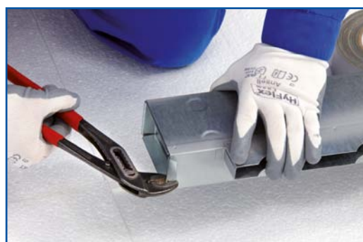
12. Zajištění víčka přihnutím výstupků (pacek)
