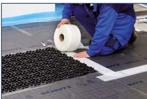
19. Zakrytí a přelepění plochých kanálů ochrannou páskou
