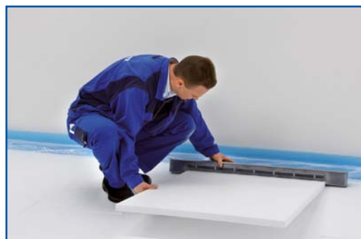
4. Vložení distanční desky do systémového modulu air conomy®
