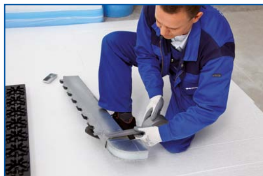
10. Utěsnění spojů v hrdlech lepicí páskou pro ploché kanály (armovanou textilní tkaninou)
