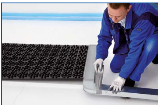
15. Montáž zbývajících plochých kanálů, utěsnění spojů páskou a přelepení kanálů
