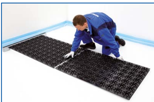
7. Montáž dalšího systémového modulu air conomy®
