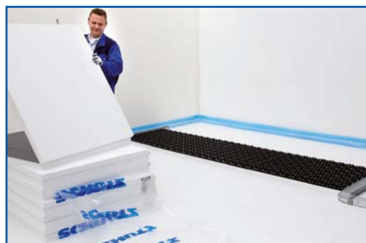
16. Položení desek aircon-takk
