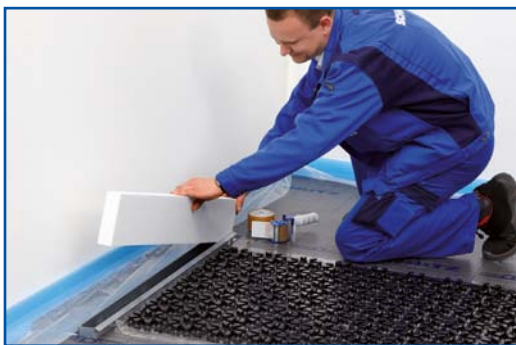
21. Vložení polystyrenového montážního bloku do skříňě vyústky
