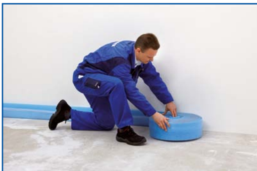
1. Položení obvodového dilatačního lemu
