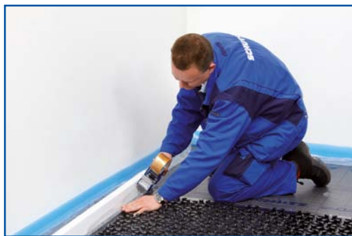
22. Přelepění polystyrenového montážního bloku
