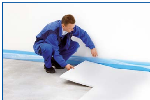
2. Položení kročejové izolace
