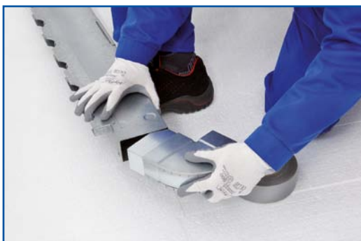
9. Montáž plochých kanálových oblouků
