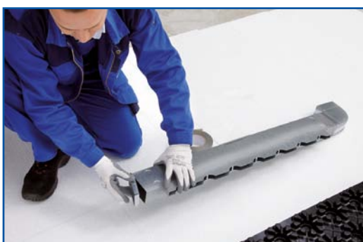
11. Uzavření otevřeného čela skříně vstupního modulu víčkem
