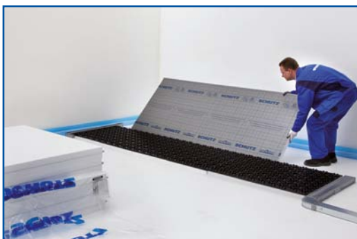
17. Položení desek aircon-takk
