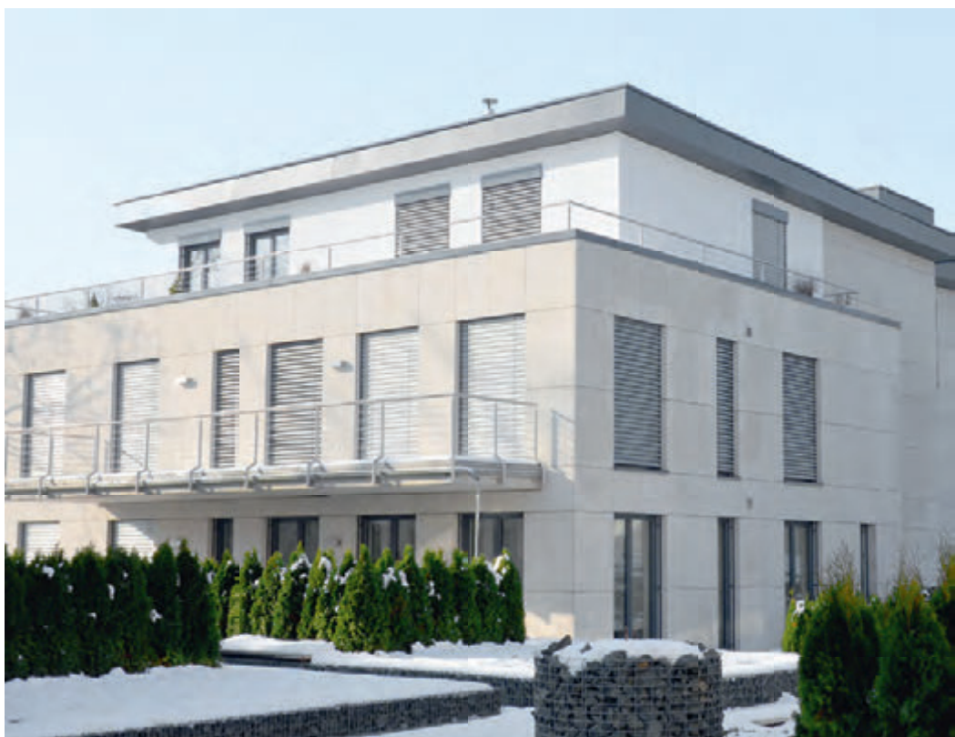
Bytový dům Bad Godesberg (D)
